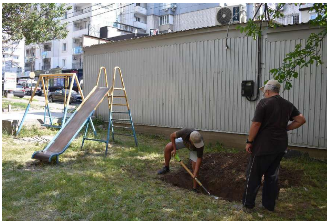
Фото. 12. Шурф № 6. Рабочий момент
