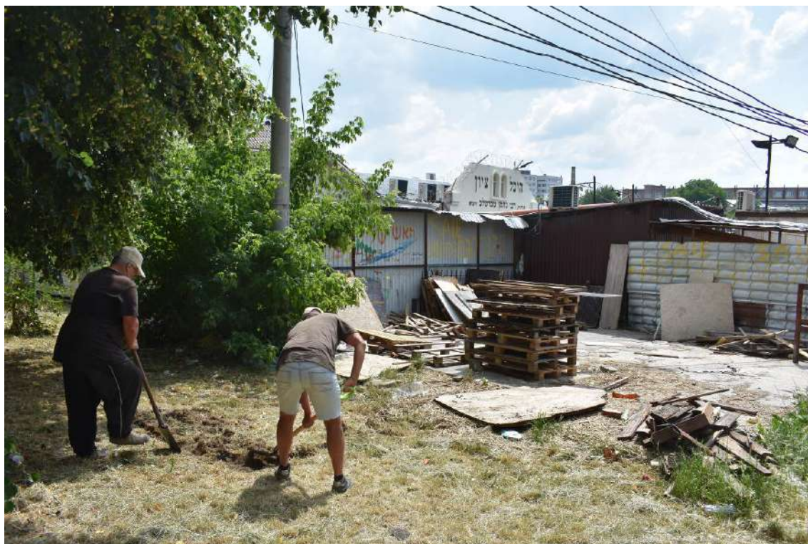
Фото. 11. Шурф № 5. Рабочий момент
